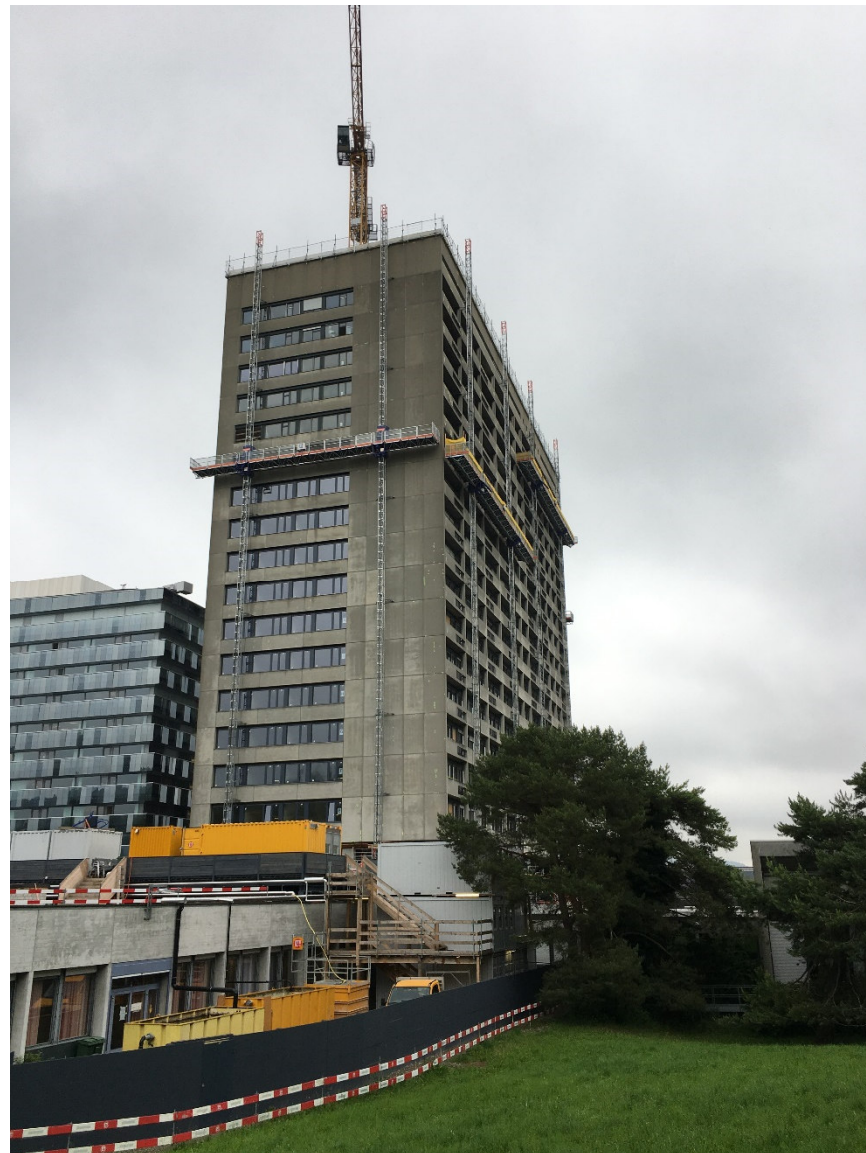
Turm mit Mastkletterbühnen in Betrieb und Kran auf dem Dach
