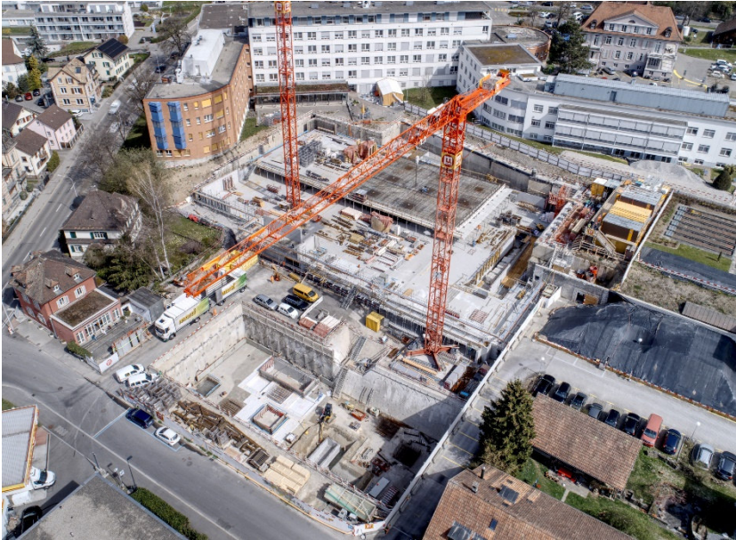
Baustellendraufsicht TG und im Vordergrund Rettungsdienstgebäude
