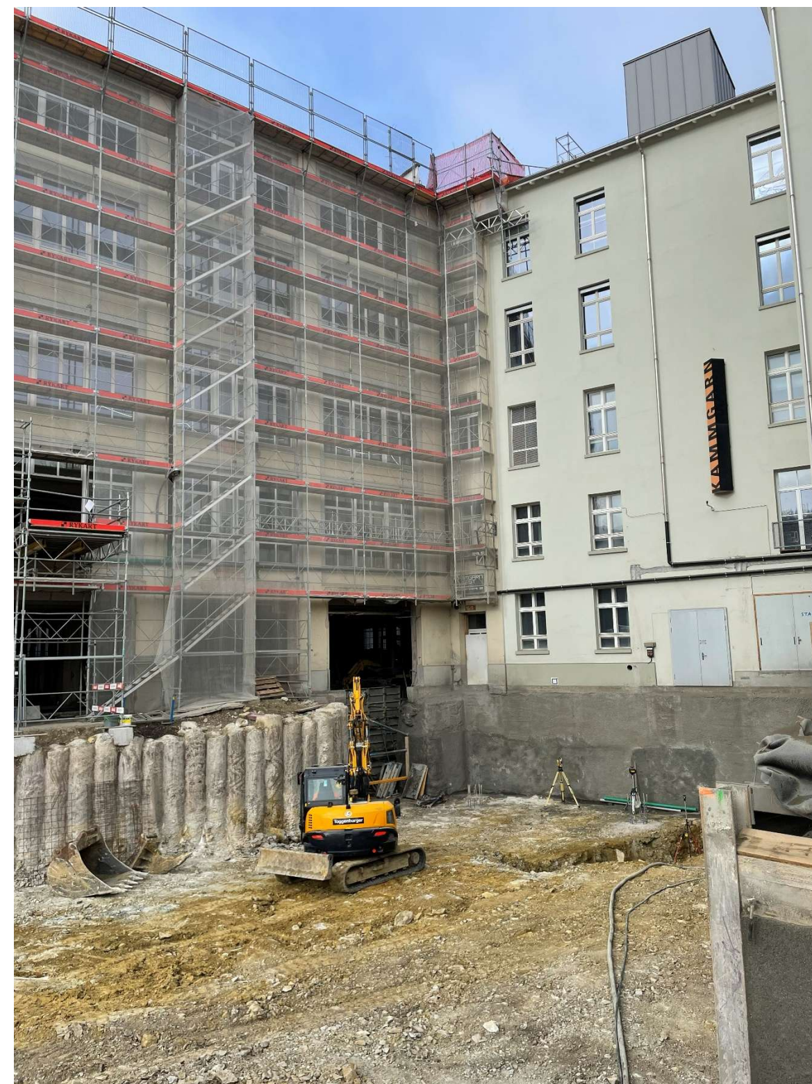
Aushub mit überschnittener Bohrpfahlwand vor Westtrakt und Unterfangung Nordtrakt
