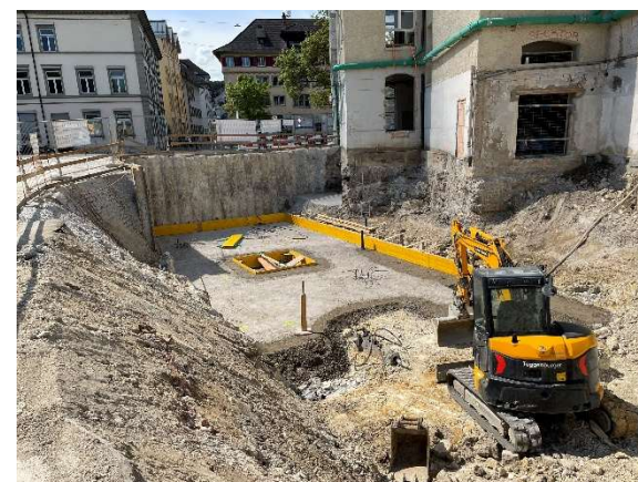
Aushub bei Westtrakt
