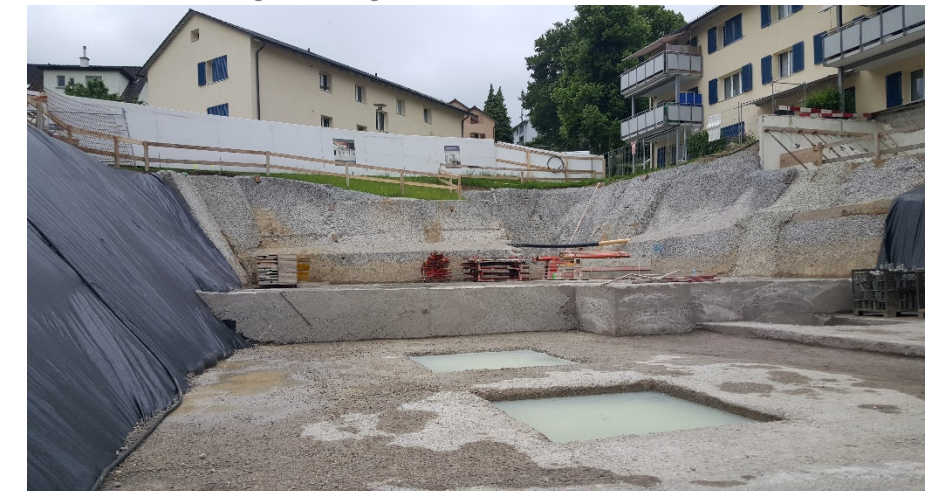
Aushub mit Böschungssicherung
