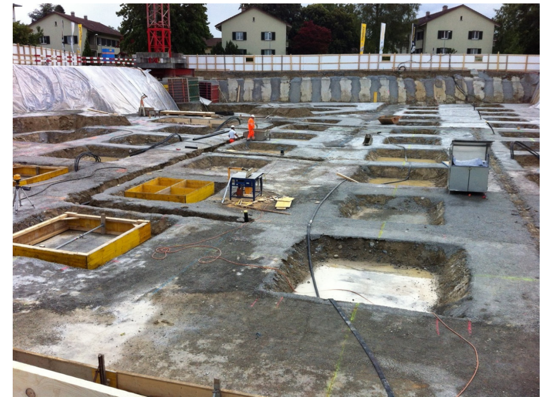
Aushub Tiefgarage mit Fundamentvertiefungen
