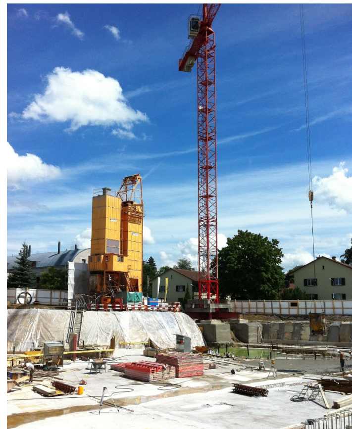
Baugrube und Bodenplatte mit der Ortbetonanlage
