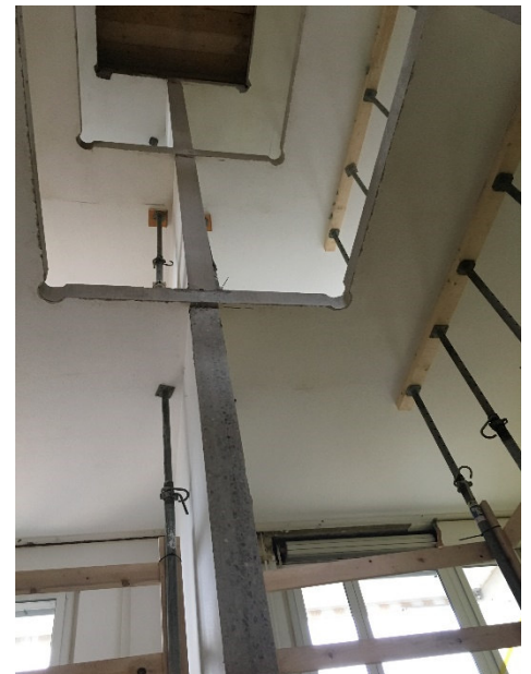
Deckenöffnungen für neuen Liftschacht
