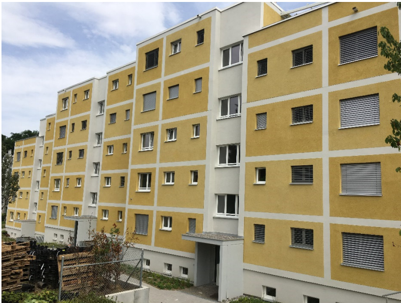
Bestehende Göhner-Elementbaute um 2 Geschosse aufgestockt
