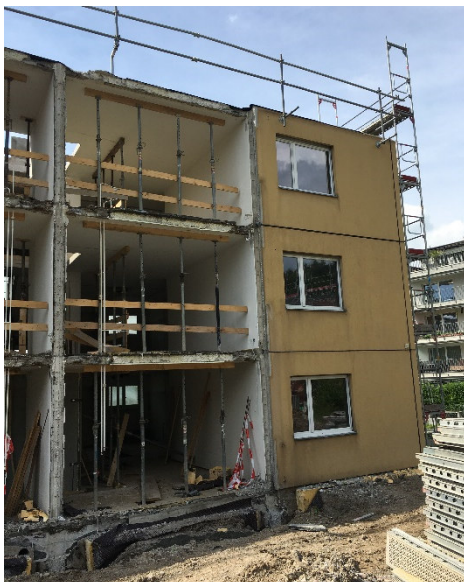
Fassadenöffnung für Wohnraumerweiterung
