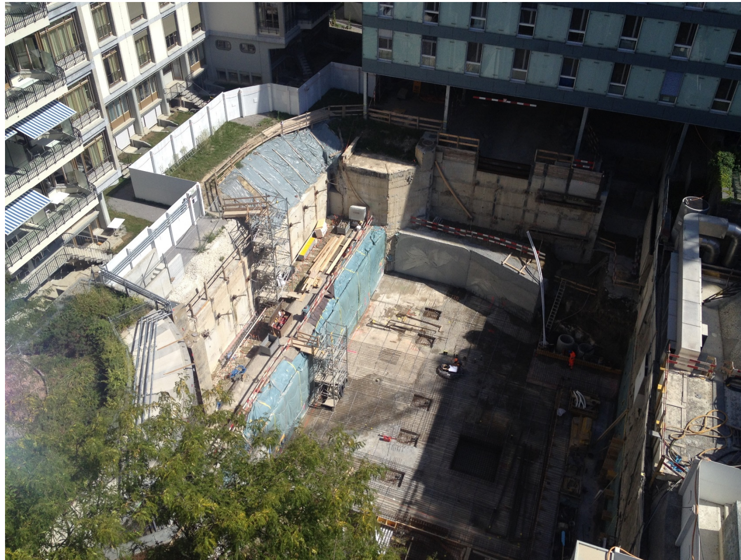
Baugrubensicherungen: Verankerte Rühlwand gegen OST und SUED 1 (links und oben), Verankerte Unterfangungen bei MR-Zentrum (rechts)
