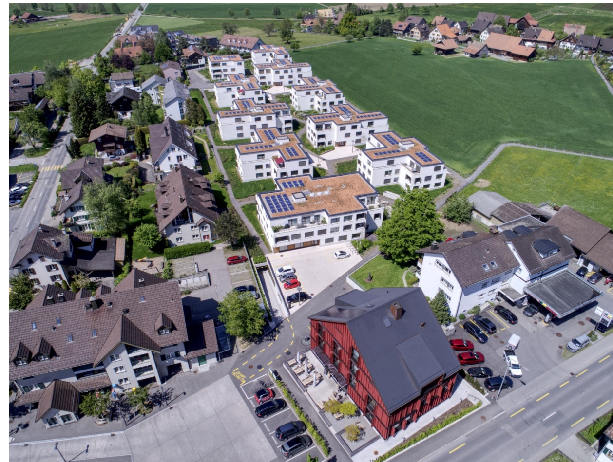
Blick Richtung Überbauung Törlematt
