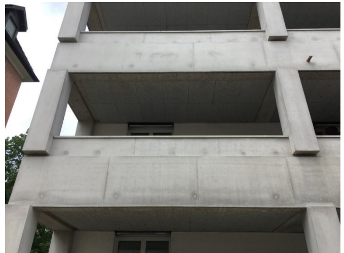
Detailansicht der Sichtbeton-Loggien
