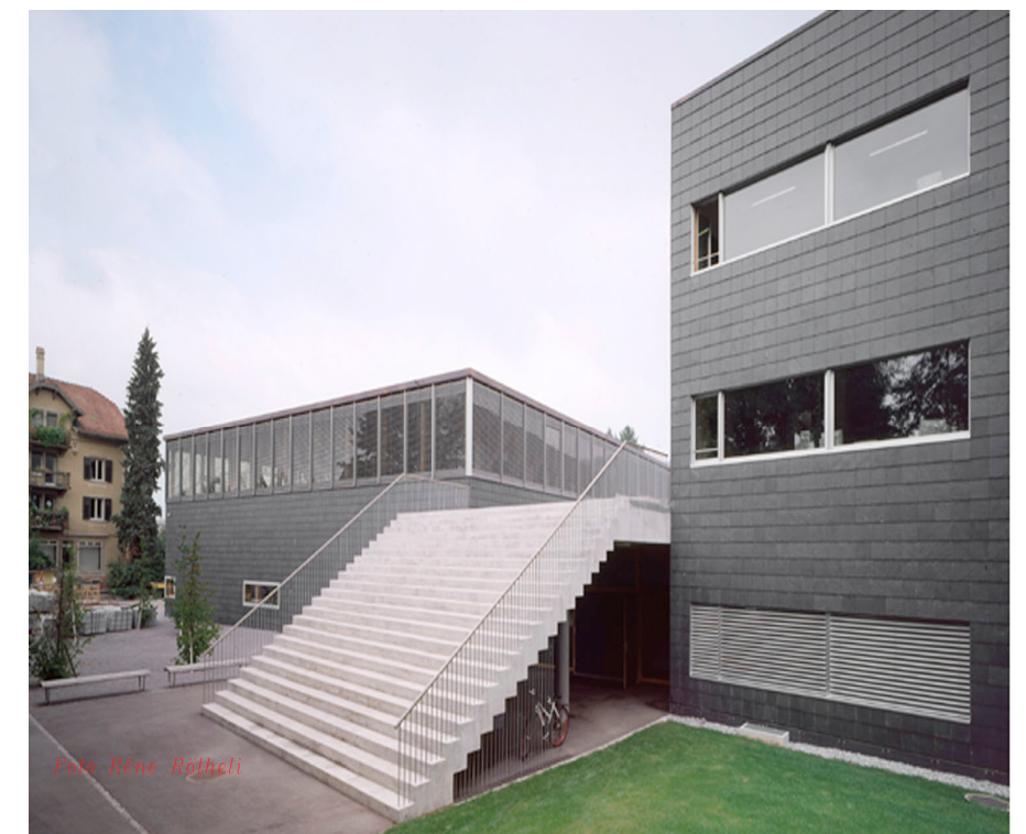
Verbindungsbau mit Aussentreppe zwischen Turnhalle und Schulhaus.
