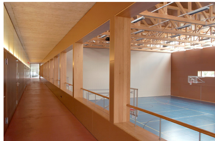
Innenansicht der Turnhalle mit Holz-Fachwerkträgern
